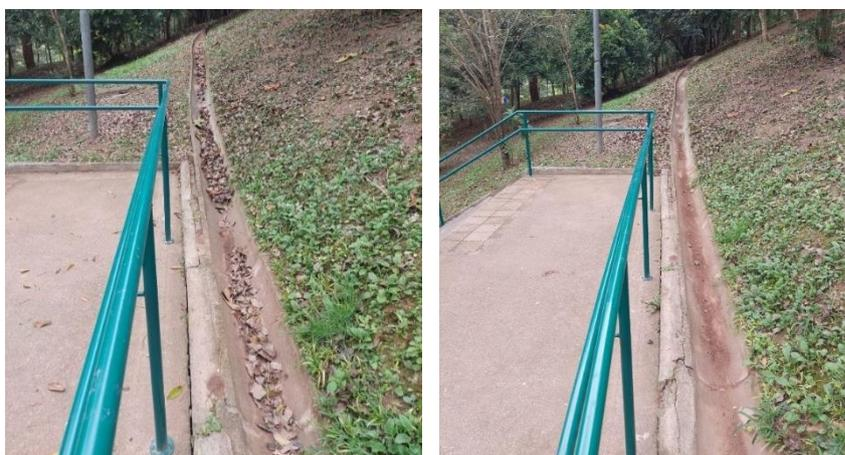
Figura 7: Limpeza nas canaletas (antes e depois)
